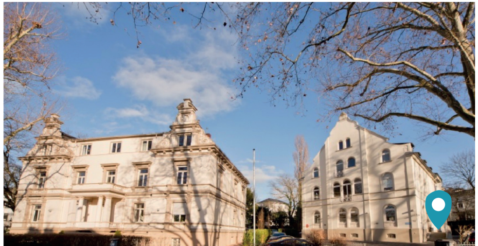
Gebäude Frankfurter Straße 10
